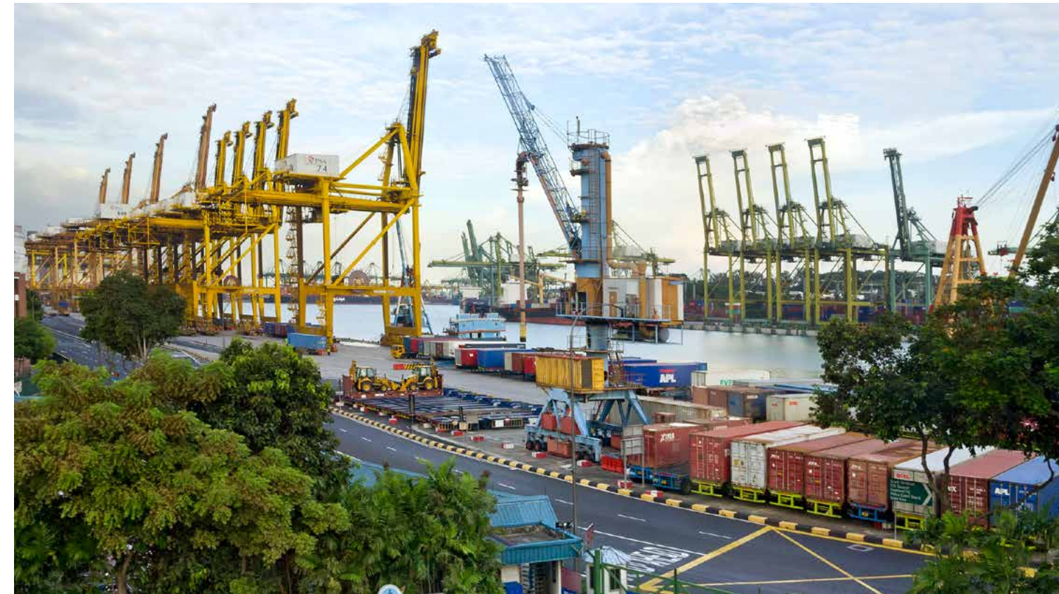
Elevación de las grúas en la terminal de contenedores Brani, Puerto de Singapur.
